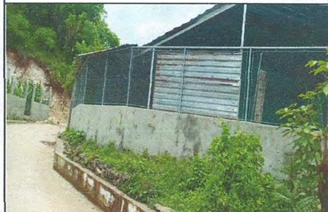
Foto 4: MANTENIMIENTO DE TECHADO DEL PATIO.
