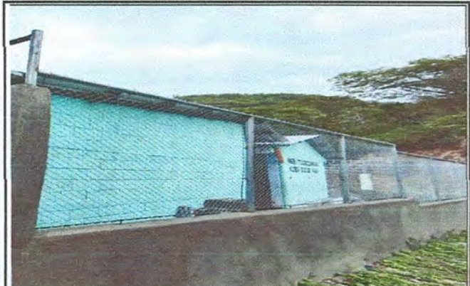
Foto 2: REMOZAMIENTO DE LA MAYA DEL MURO PÉRIMETRAL.
